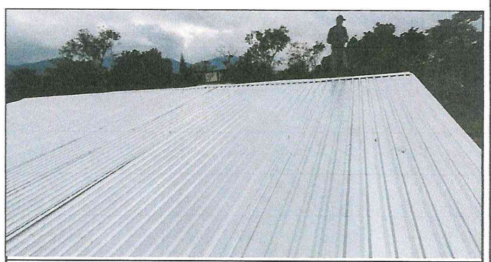
Foto 6: Colocación de lámina
