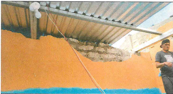
Foto 3: Instalación de energía eléctrica y lámina
