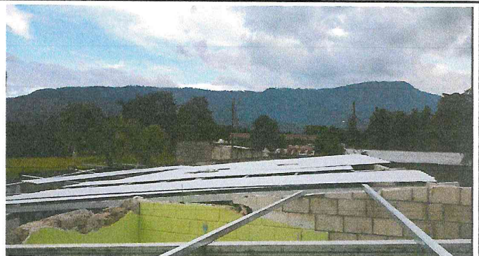
Foto 2: Colocación de costaneras
