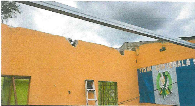
Foto 1: Desmontaje de techo
